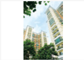
Chung cư CANTAVIL Giai Đoạn I (Quận 2)
