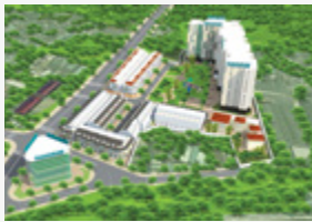
Khu đô thị PHƯỚC LONG SPRING TOWN (Quận 9) - Đang triển khai
