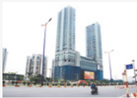
Chung cư CANTAVIL PREMIER (Quận 2)
