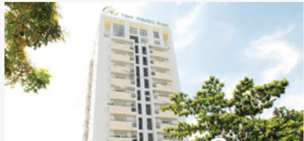
Chung cư TDH – PHƯỚC BÌNH (Quận 9)
